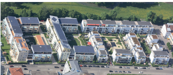
Abb. 50: Luftbild der Plusenergiesiedlung
