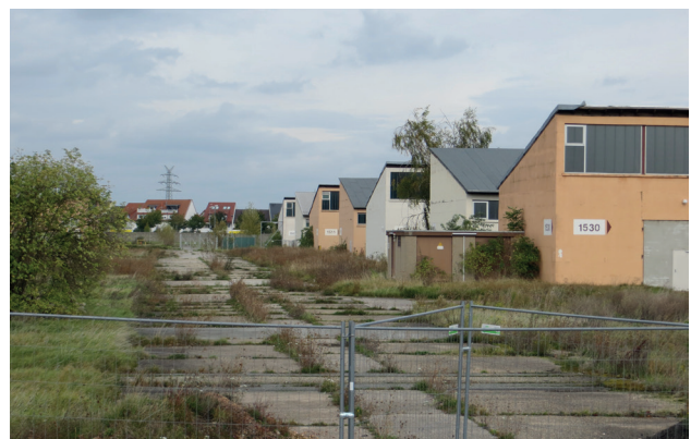
Abb. 60: Blick auf die derzeit ungenutzten Kasernengebäude
